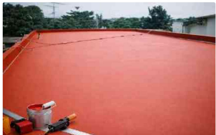
IMPERMEABILIZACION DE LOSAS
