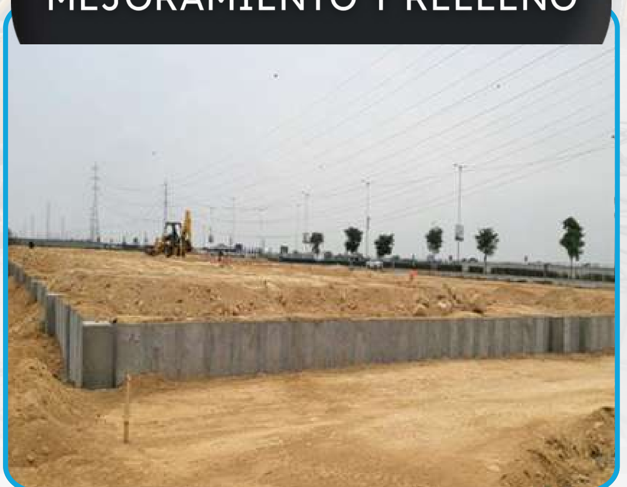
MEJORAMIENTO Y RELLENO
